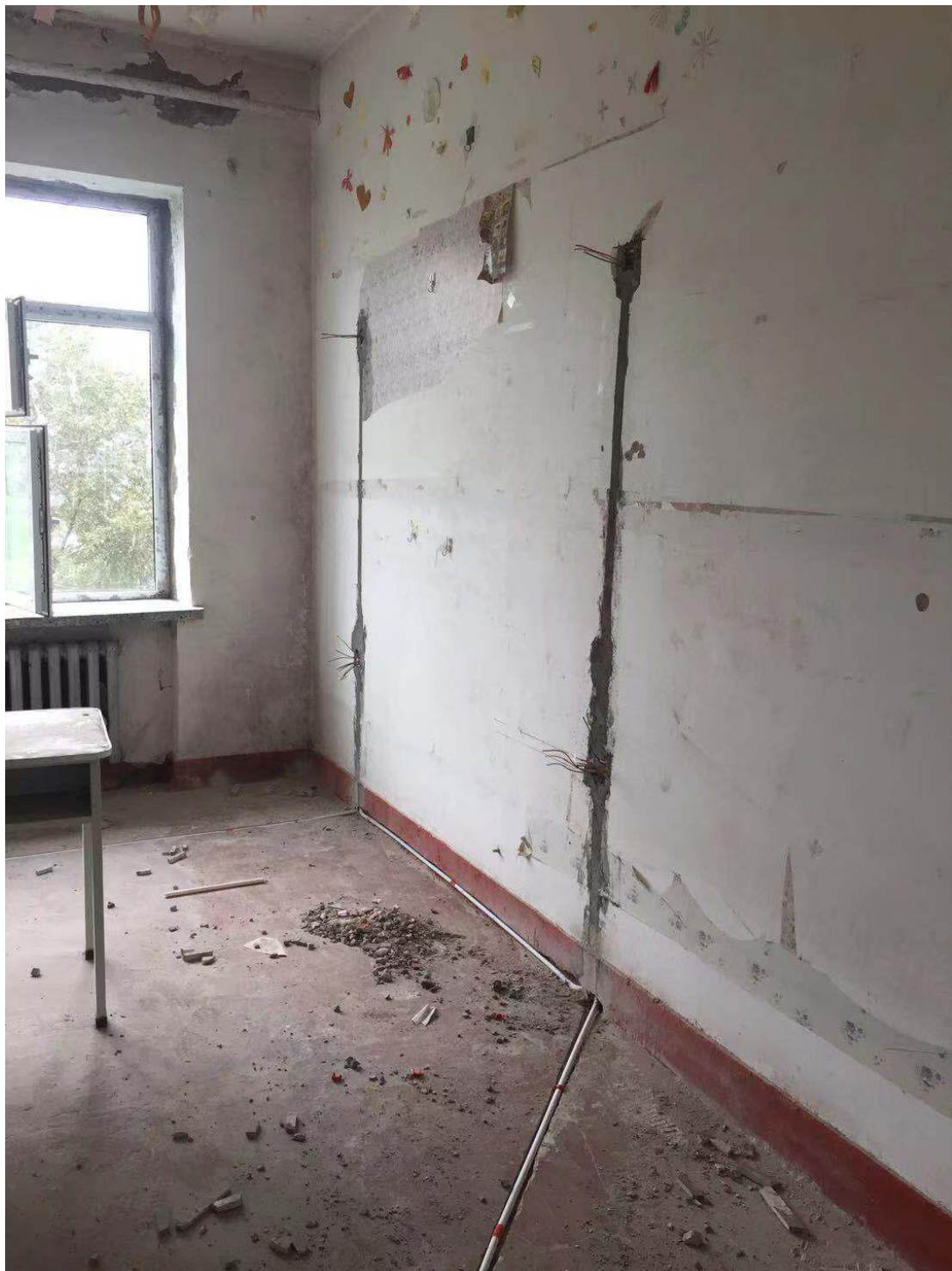
C10#楼水电布线中
